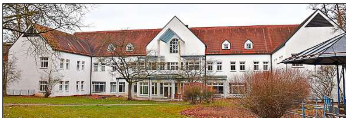
Die Rehabilitationsklinik Alkure soll im ehemaligen Pflegeheim, im Gebäude B13, untergebracht werden. Die Kosten für die Sanierung des neuen Standortes, dessen Erweiterung und der Umzug werden auf über 1,8 Millionen Euro geschätzt. – Foto: Bezirksklinikum
